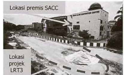
轻快铁第三路线工程在会展中心方圆50公尺内进行，加上部分路段因施工而关闭，影响了大型活动的筹办，令会展中心去年的营收下滑。
